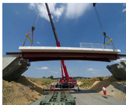
Ponte in plastica (Località Friedberg – Germania)
